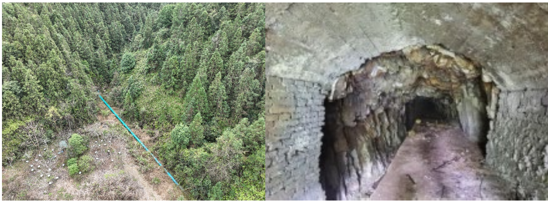
图 1 旧管道及输水隧洞现状
