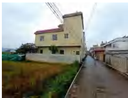
自来水供水管
